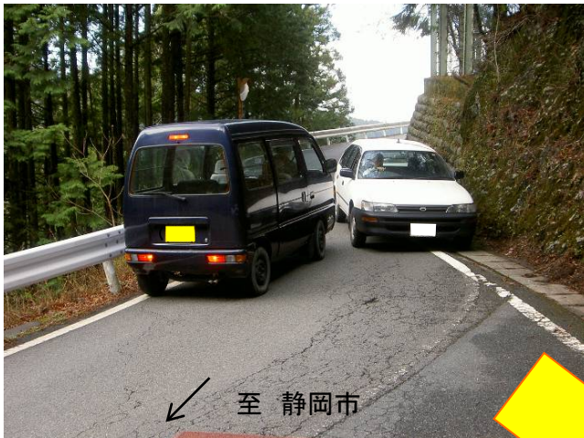
① <未整備区間>
