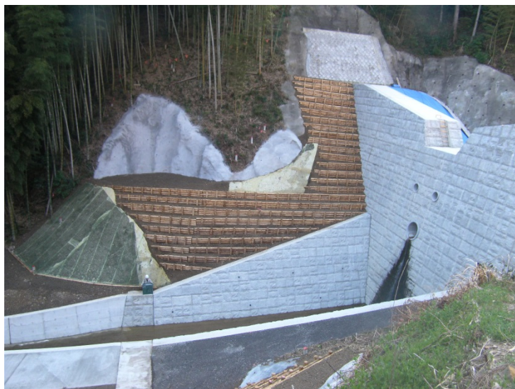
袖部施工直後
