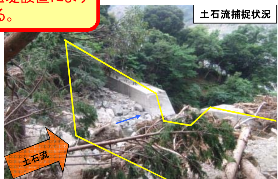
土石流を堰堤で捕捉
