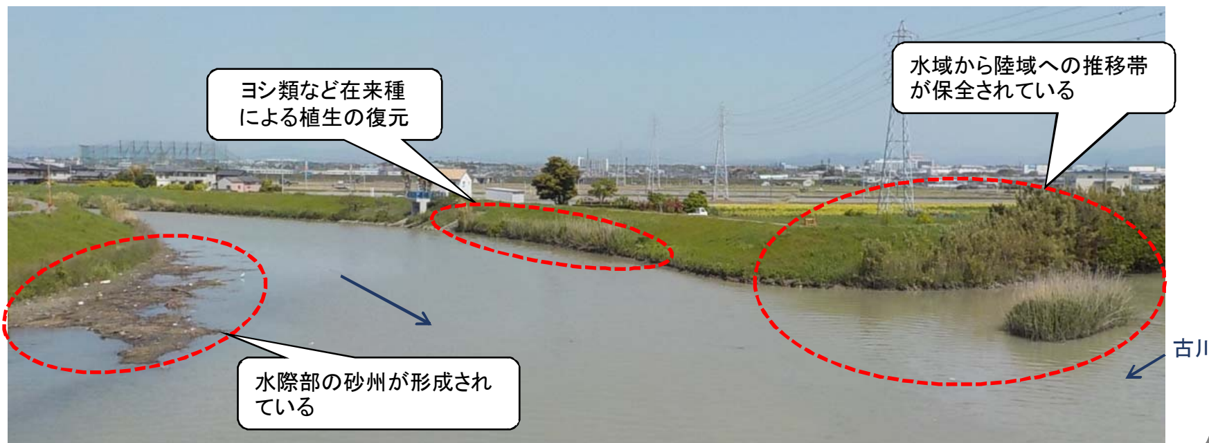
大西橋上流の河道状況
