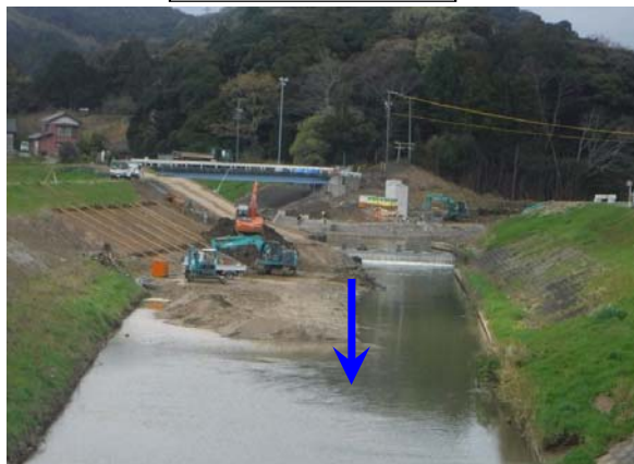
中沢川合流点付近(施工中)
