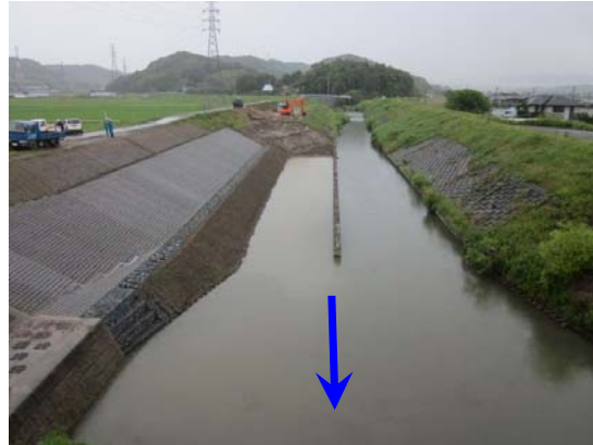
新笠梅橋上流(施工直後・H25年時)
