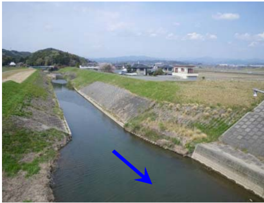
新笠梅橋上流(未改修・H23年時)
