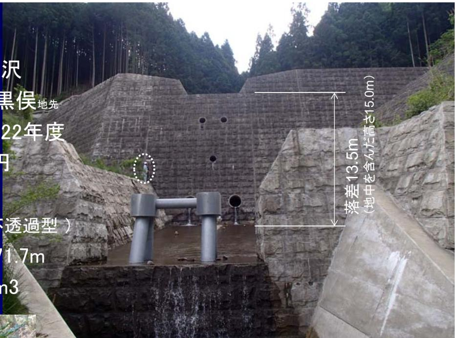
堰堤工（不透過型）下流正面より
