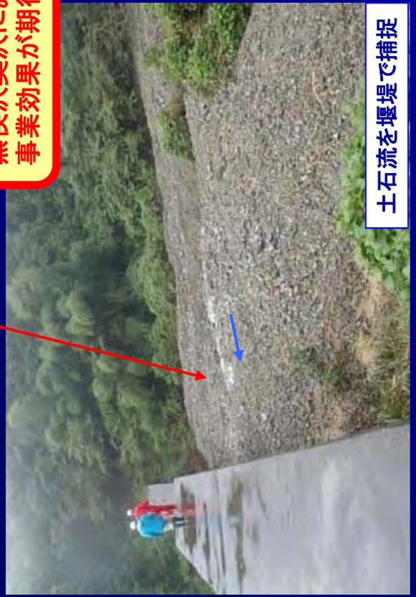
土石流を堰堤で捕捉
