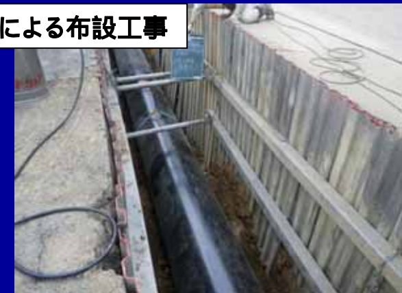
推進工法による布設工事
