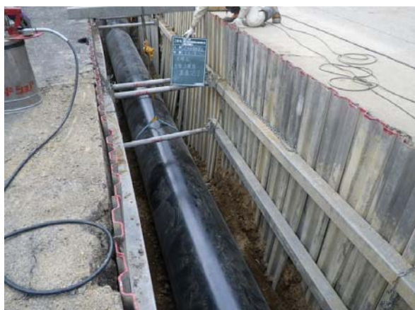
開削工法による管路布設
