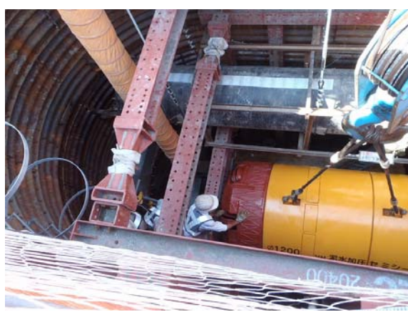
推進工法による管路布設
