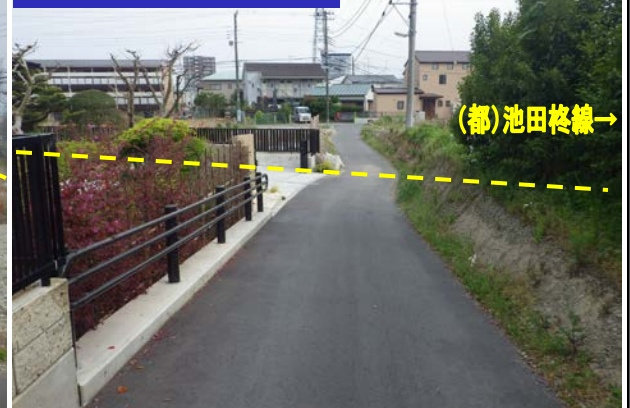
工事の進捗状況写真
