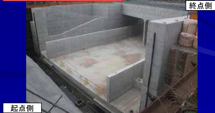
②西側区間の工事進捗状況
