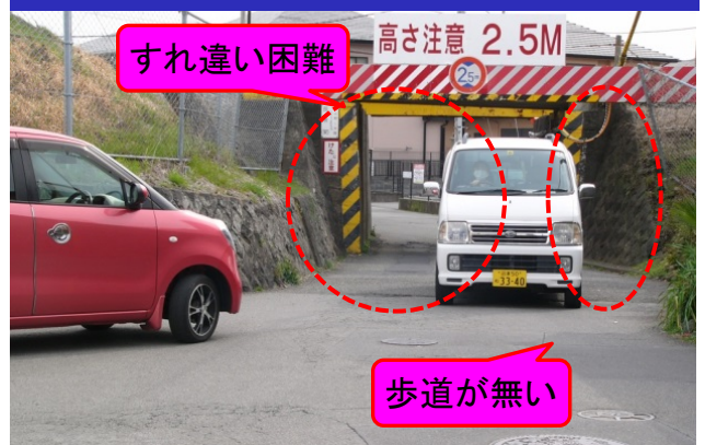
②町道鮎壺薄原線(すれ違い困難、歩道未整備)
