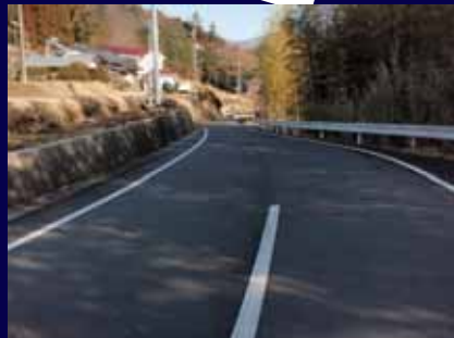
保全対象(県道)状況
