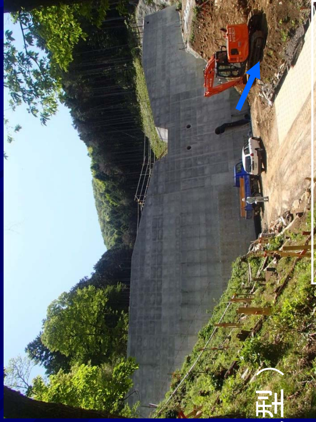
堰堤工(不透過型)下流正面より
