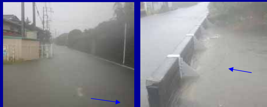
平成26年台風18号による浸水状況(新橋付近)
