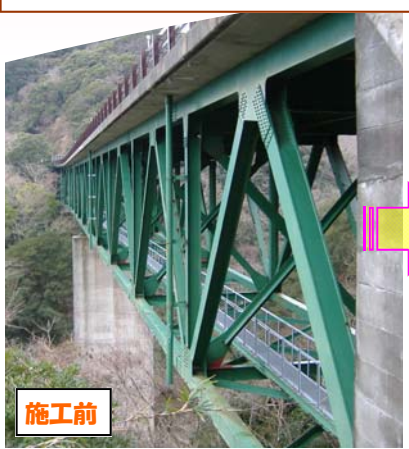
平成22年度完成 天狗橋塗装塗替工事（南伊豆町）
