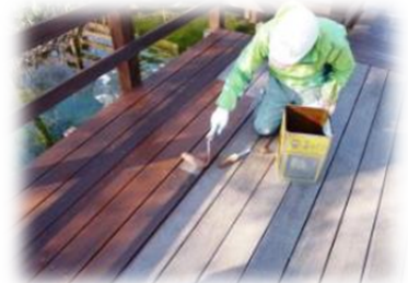
ウッドデッキの塗装の様子
