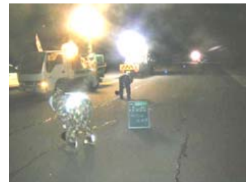
ひび割れ補修 (誘導路)
