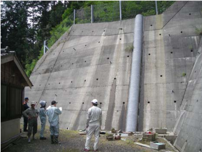
急傾斜地パトロール（静岡土木事務所） ・ 擁壁のクラックの有無を確認中
