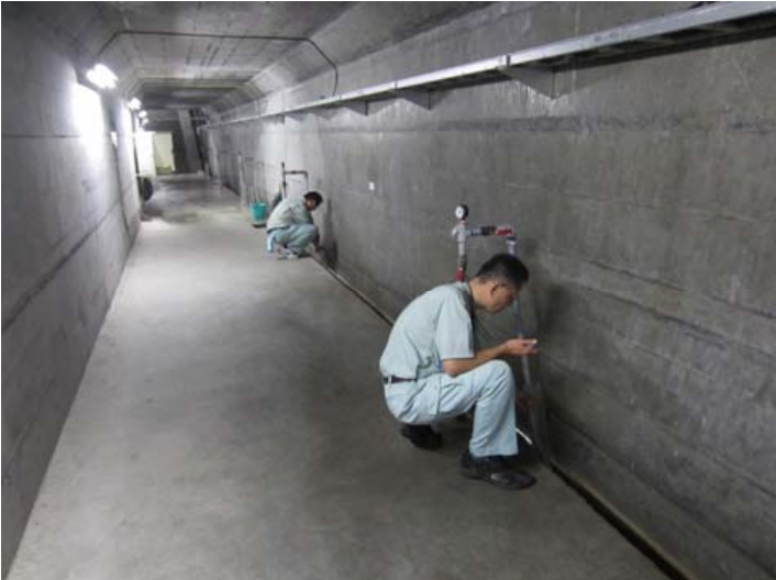
日常巡視（袋井土木事務所） ・ 漏水量を計測中
