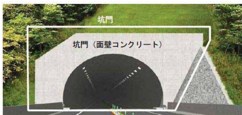
図 1.2 点検対象箇所（トンネル坑口部） 1)
