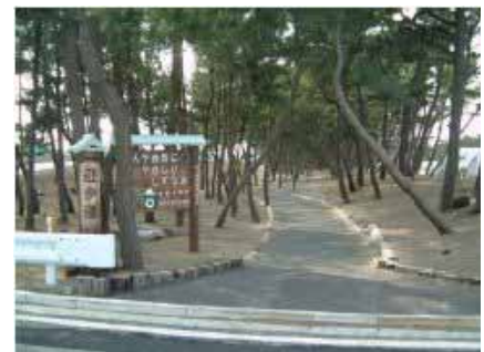
協働により整備された海岸防災林
