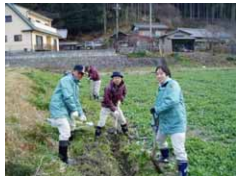
(株)フジヤマとの協働作業(排水路の整備)
