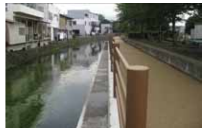
完成: 田宿川のせせらぎと遊歩道
