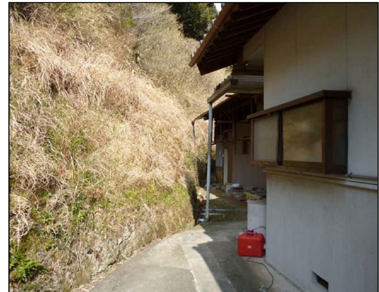
擁壁工(整備予定箇所)
