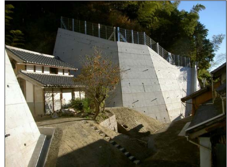
①擁壁工(整備済箇所)
