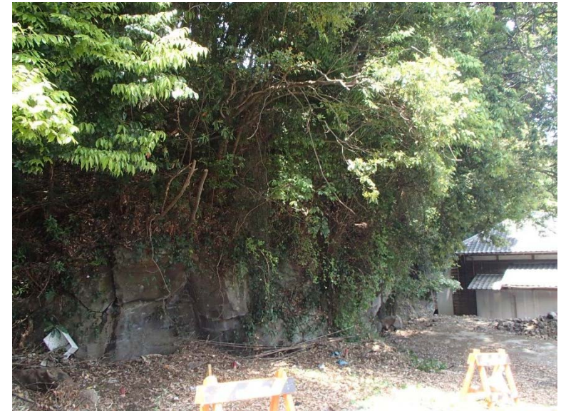
①整備予定箇所(法面工)
