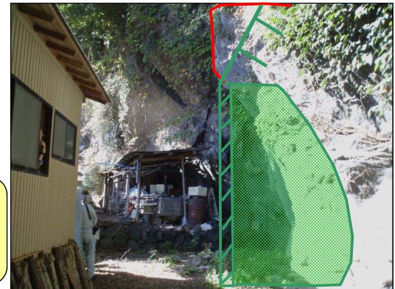
②整備予定箇所(法面工・保護壁工)
