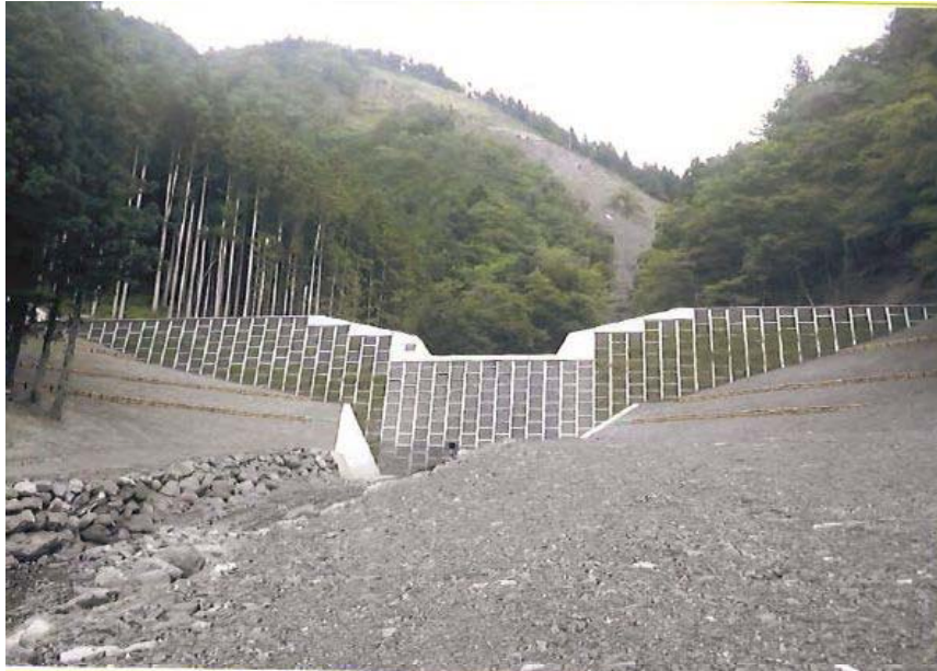
完成時（平成26年8月）
