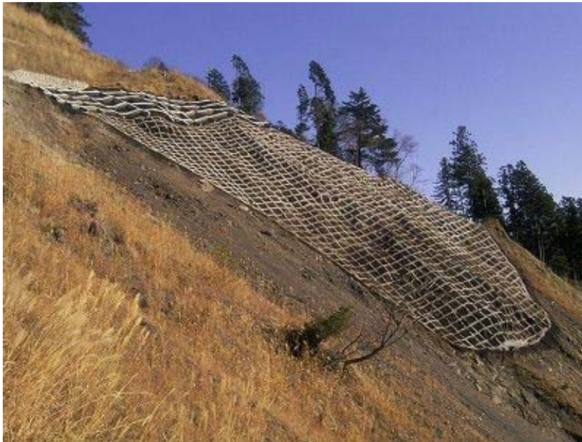
完成時（平成21年11月）
