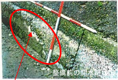
漏水の原因となるひび割れ
