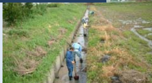
排水路の土砂上げ
