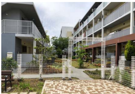
共用庭の整備による良好な環境づくり
