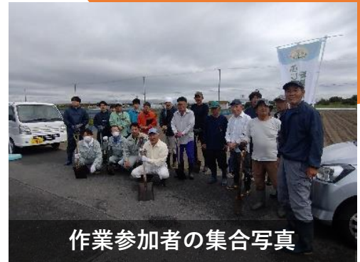
泥上げ作業の様子
