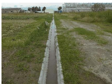
整備されたCo製側溝
