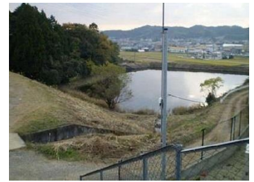
天白下池工事着手前
