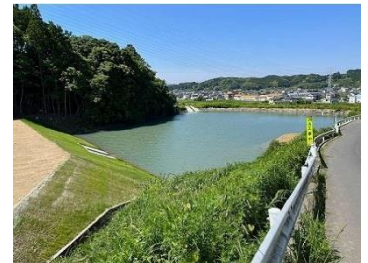
天白下池工事完了後
