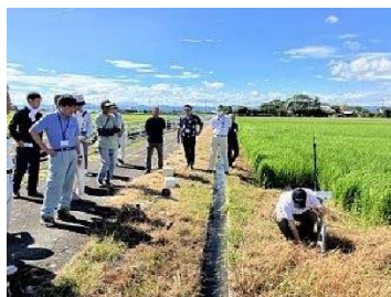
給水ゲート設置の様子
