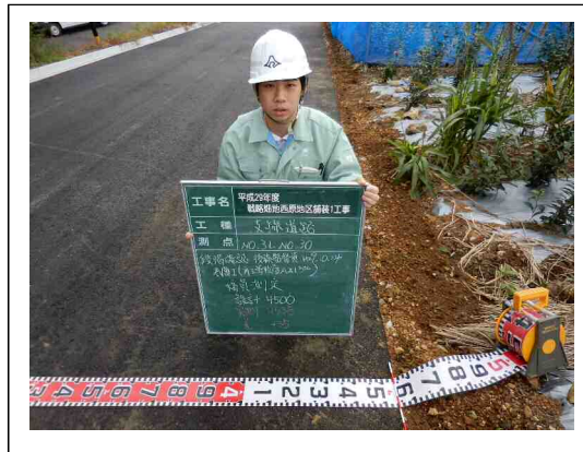
アスファルト舗装の幅員測定
