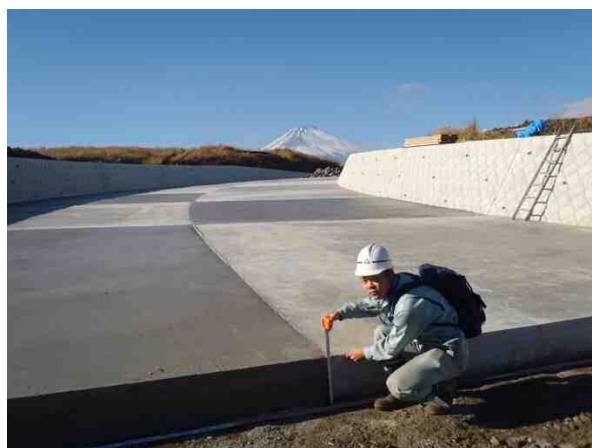
【工事監督業務の様子】
