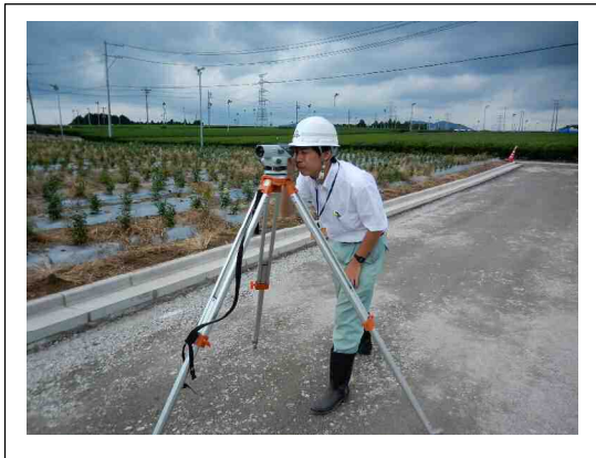
路盤の基準高測定
