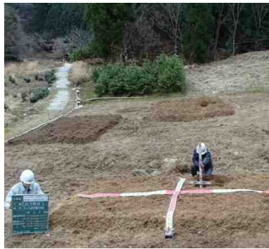
荒廃農地対策の工事
