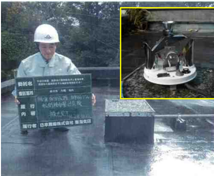
ダム管理用機器の点検・交換
