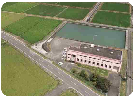
浅羽揚水機場（袋井市）
