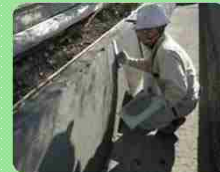
開水路の補修
