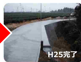
崩落した農道法面の復旧 （牧之原市谷田地区）
