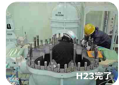
ポンプ点検補修
