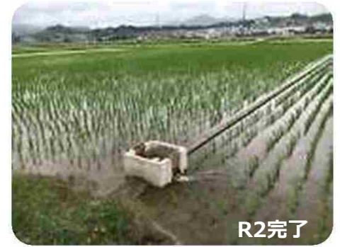
水田用水のパイプライン化 (浜松市中川地区)
