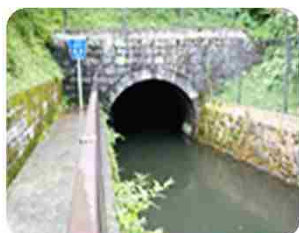
深良用水隧道出口
