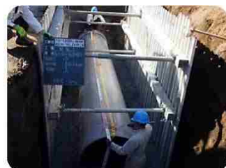
農業用水管改修（裾野市）
