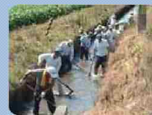
水路の泥上げ
