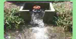
用水のパイプライン化 (水田給水バルブ)
