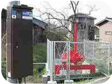
除塵機の設置
