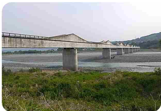
大井川水路橋（島田市）
