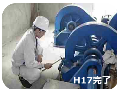
頭首工ゲート点検
