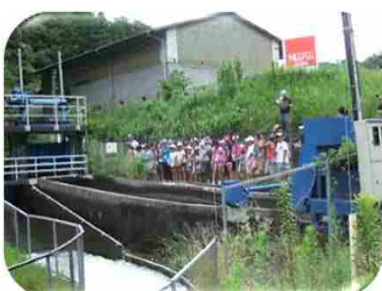
地域住民対象の施設見学会 (菊川市他3市大井川右岸地区)
