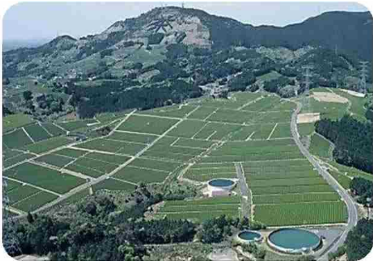
国営掛川調整水槽 (掛川市)
