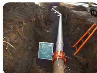
用水管補修（御殿場市）
