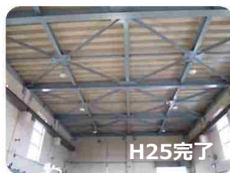
排水機場（建屋）の補強 （伊豆の国市堂川地区）
