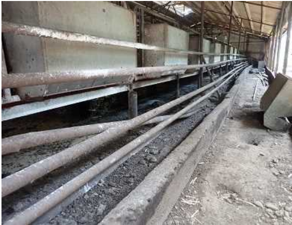
写真6 離乳舎内の様子（運用後）
