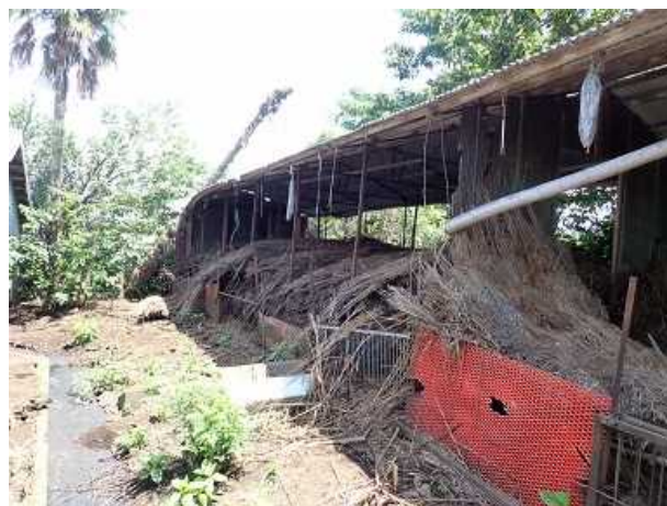
写真1 藁小屋(処分前)
