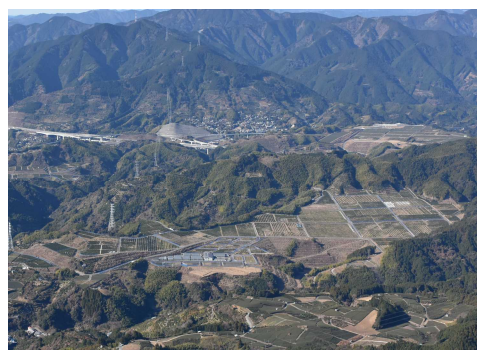
令和2年度に大規模基盤整備が完了した 静岡市清水区茂畑地区（静岡市清水区）
