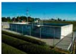
金谷28工区ファームポンド
