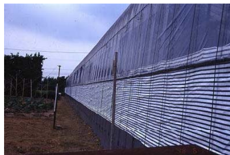
光反射ネットによる害虫侵入防止
