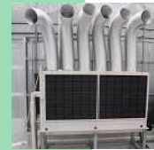
(ヒートポンプ)
