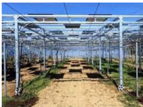
キウイフルーツ園への発電設備の設置状況
