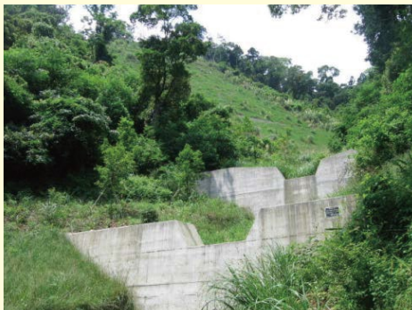
溪床勾配を 緩和し土砂の 流下を防止
