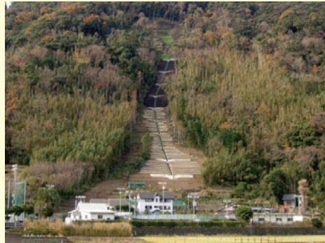
山腹工による 崩壊地の復旧
