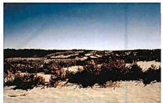
浜岡町浜岡砂丘における堆砂工 砂丘上の飛砂を固定し、観光地としての砂丘を保護するために、堆砂工を実施しています。(平成13年2月撮影)
