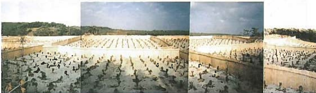
静砂垣工と植栽工の様子(平成11年度施工 浜岡町池新田)
