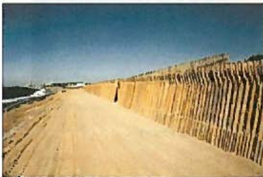
間伐材を利用した防風柵工
