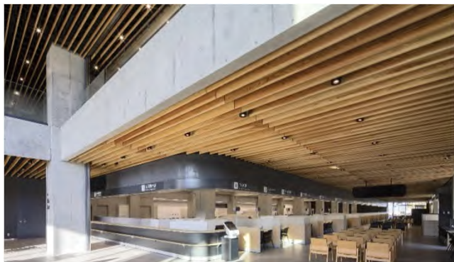
島田市役所新庁舎
