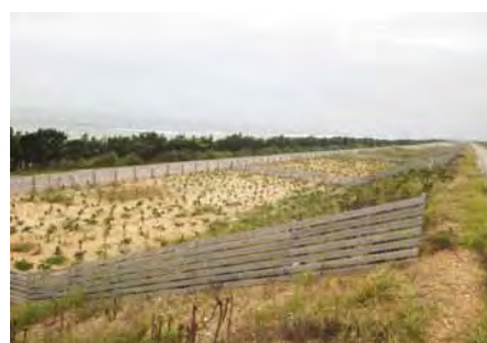
【遠景(防潮堤天端より)】
