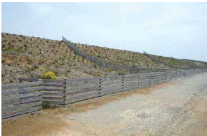
【静砂工設置状況】
