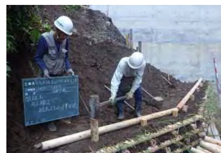
【施工状況 杭木の打ち込み作業】
