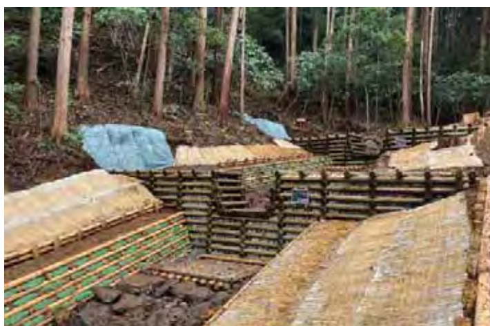
【木製治山ダム完成時】
