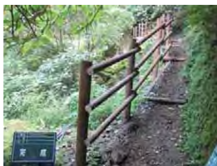
【転落防止柵起点側】
