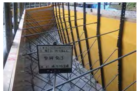
【施工状況 カチオンフレーム使用中】
