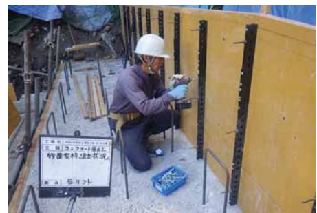
【施工状況 残存型枠組立】
