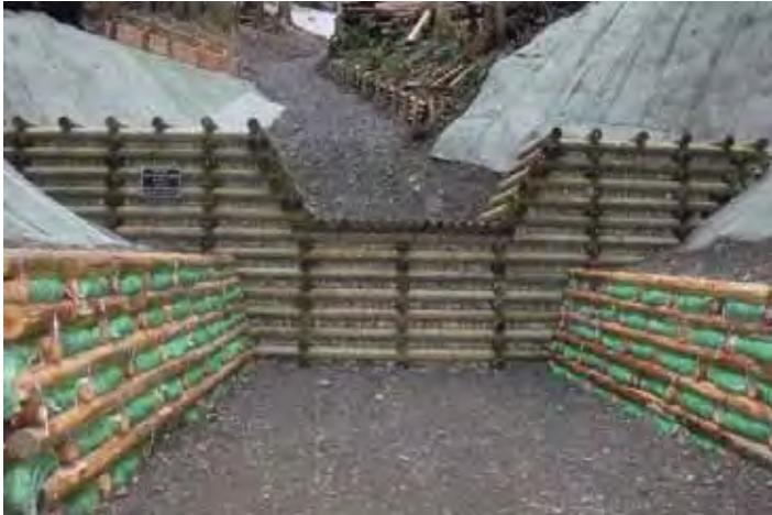
【木製校倉式床固工】
