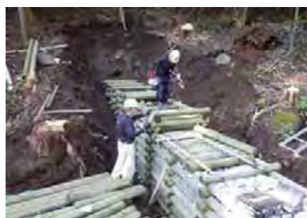
【施工状況 丸太組立て】
