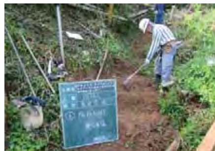
【施工状況-階段切付】
