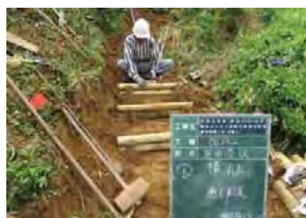
【施工状況-横丸太設置】
