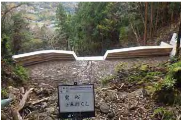
【谷止工背面の状況】
