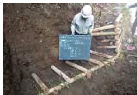
【施工状況 横木、控木、カヤ株の施工】
