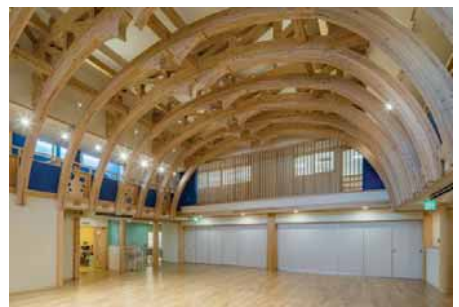
【曲線トラス架構を見せるインテリアとした】
