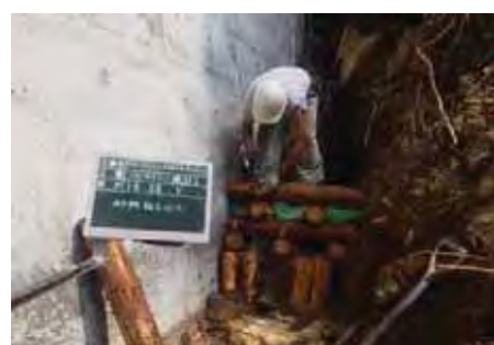
【丸太積間詰施工中】
