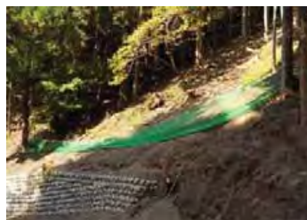
木柵設置前の状況
