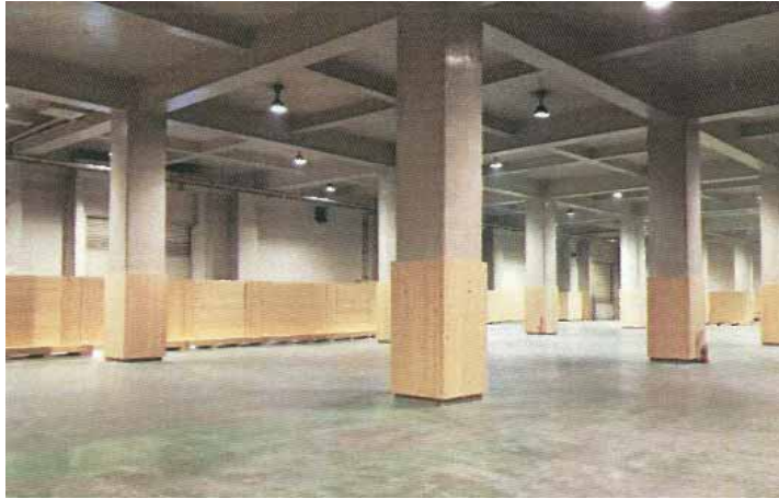
【改修後全体写真】
