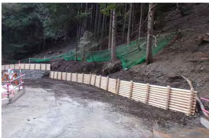
【資材搬入路の山側に木柵を設置】
