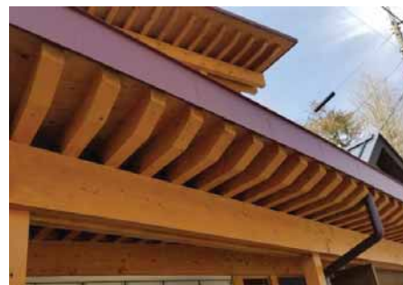
【柱を挟む二重梁と垂木】
