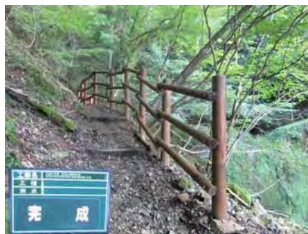
【転落防止柵終点側】
