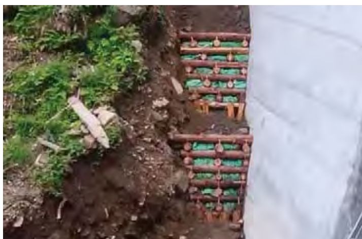
【丸太積間詰完成時】
