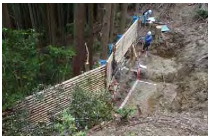
【防護柵設置完了】
