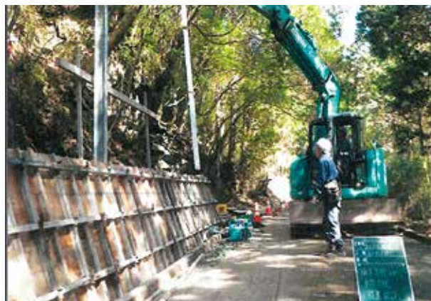
施工中（R6完成予定）
