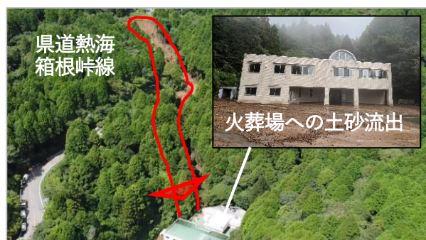
斜面崩壊による土砂流出（熱海市熱海）
