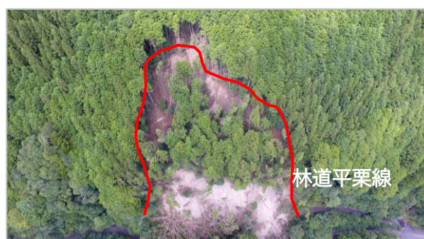
大規模山腹崩壊地（榛原郡川根本町東藤川）
