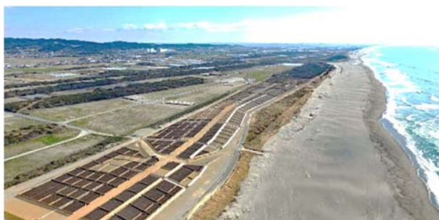
ふじのくに森の防潮堤の整備（掛川市沖之須）
