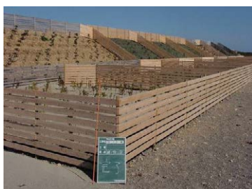
防風工 （浜松市南区） 製材品を利用した防潮堤整備事業
