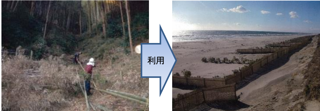
伐採した竹材を掛川市の海岸防災林で堆砂垣に利用
