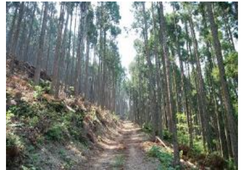
開設した作業車道
