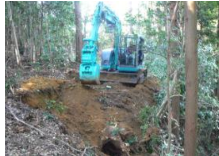
作業車道の開設
