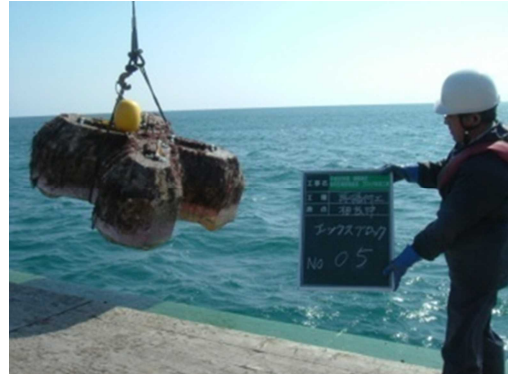
図4 クレーンを使って敷設
