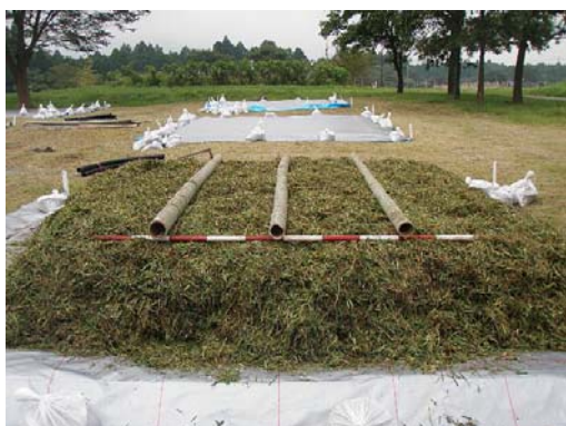
写真4 50cm 堆積の上に竹通導管を設置
