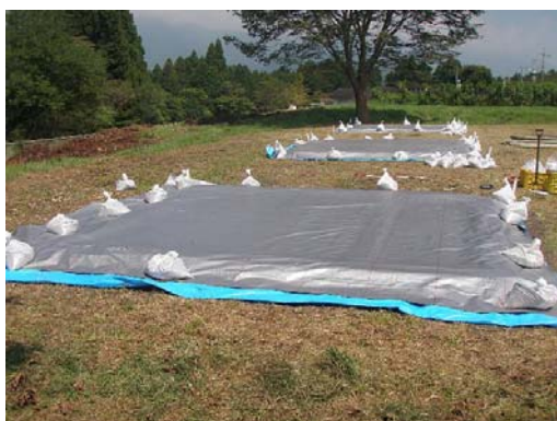
写真2 土塁で囲った区画に不透水シートを設置
