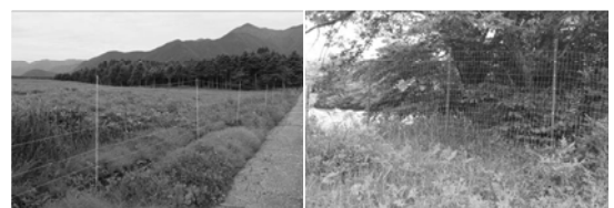
電気柵(=心理柵) →ショックで心理的にシカの行動を制限 ・柵高1.5m以上、地際0.2m未満に4段 メリット：コスト安い、設置・修理簡単 デメリット：手間がかかる(破損しやすい)、シカが覚えるまで破損が多い 金網柵(=物理柵) →物理的にシカの行動を妨げる ・柵高2.0m以上、地際折返し、網目15cm以下 メリット：耐久性がある デメリット：設置・修理が困難で高コスト
